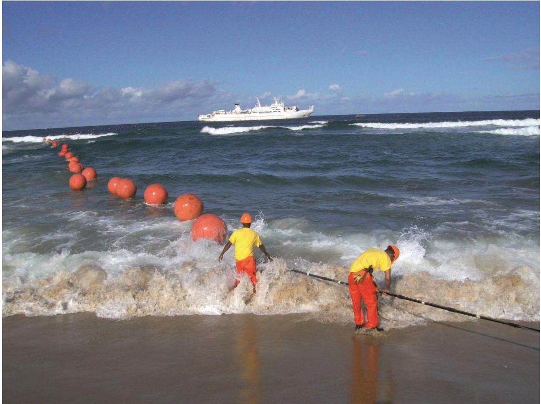
Pose d'un câble sous-marin par le navire câblé Chamarel . © Orange Marine.
