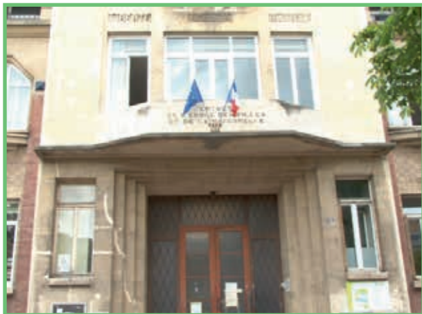
La façade de l'école
