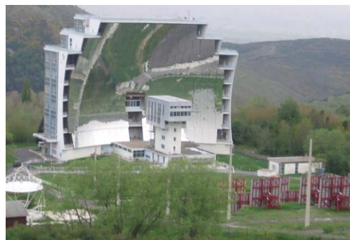
Le four solaire d'Odeillo 20 fois plus grand que celui de Mont Louis, on y teste des matériaux qui doivent résister à des chaleurs extrêmes, par exemple pour l'industrie spatiale.
